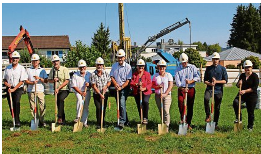
Die Gründungs- und Vorstandsmitglieder gaben den Startschuss für die Bauarbeiten. fst
